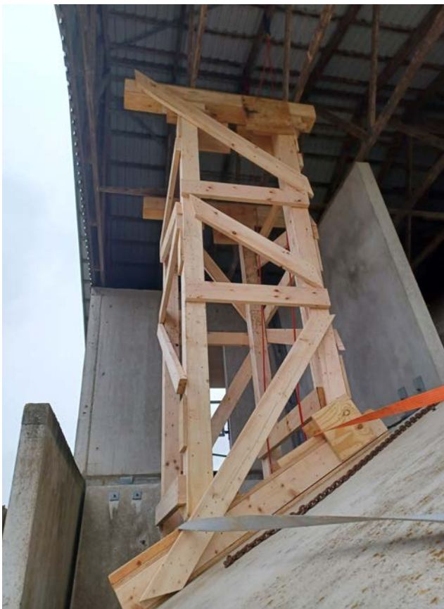
Afstivninger kan laves i alle afskygninger alt efter opgave. Her ses en avanceret afstivningstype.
