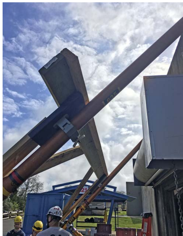
Topforstærkningen er sømmet sammen med en 2"x4" så den er mere stiv. Det samme skal gøre på bundsforstærkningen.
