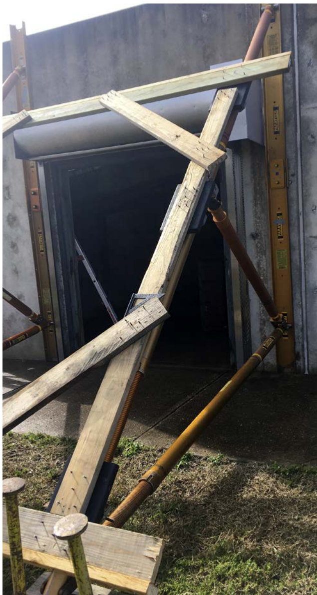
Der ligger en speedsquare på lederen så man kan se at forstærknings-tømmeret ligger i 45^{\circ} .
