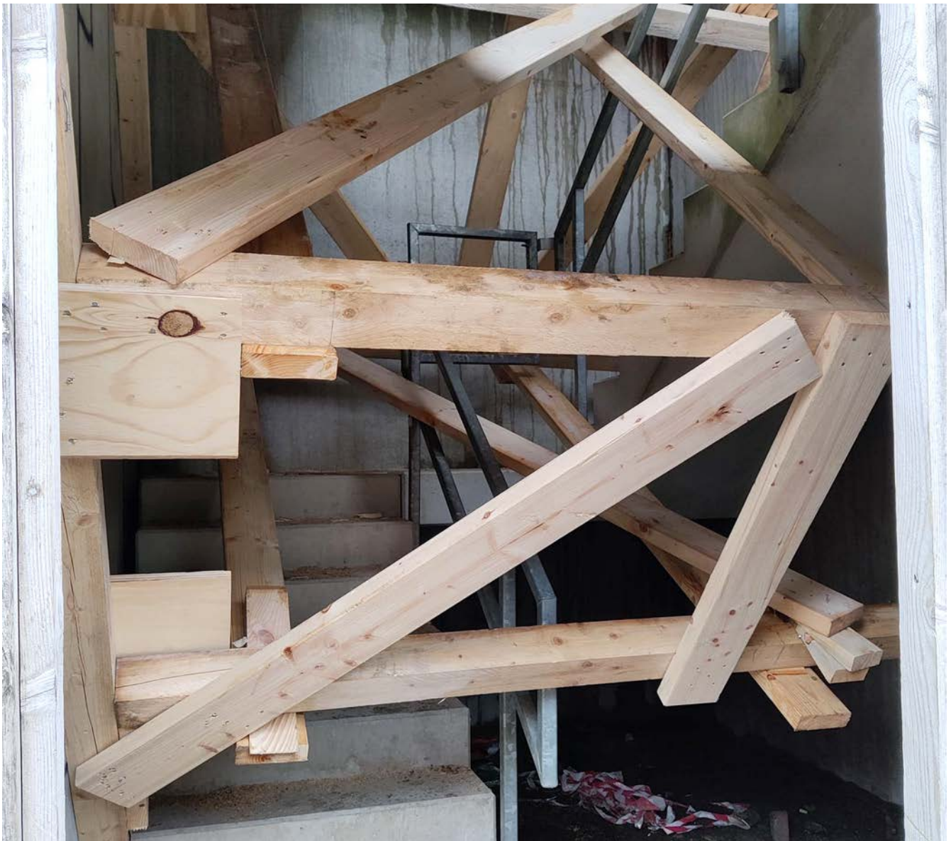
Afstivning opsat, hvor en trappeopgang truer med at styrte sammen.
