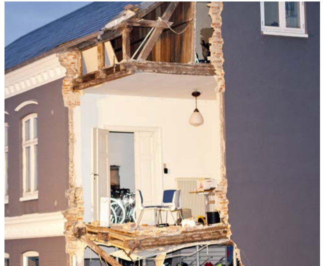
Toppen af konstruktionen er både tag og overliggende etager
