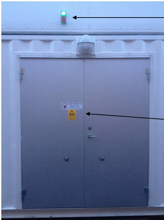
Dør til kompressor- og/eller produktionsrummet med advarselsslamper og -skilte
