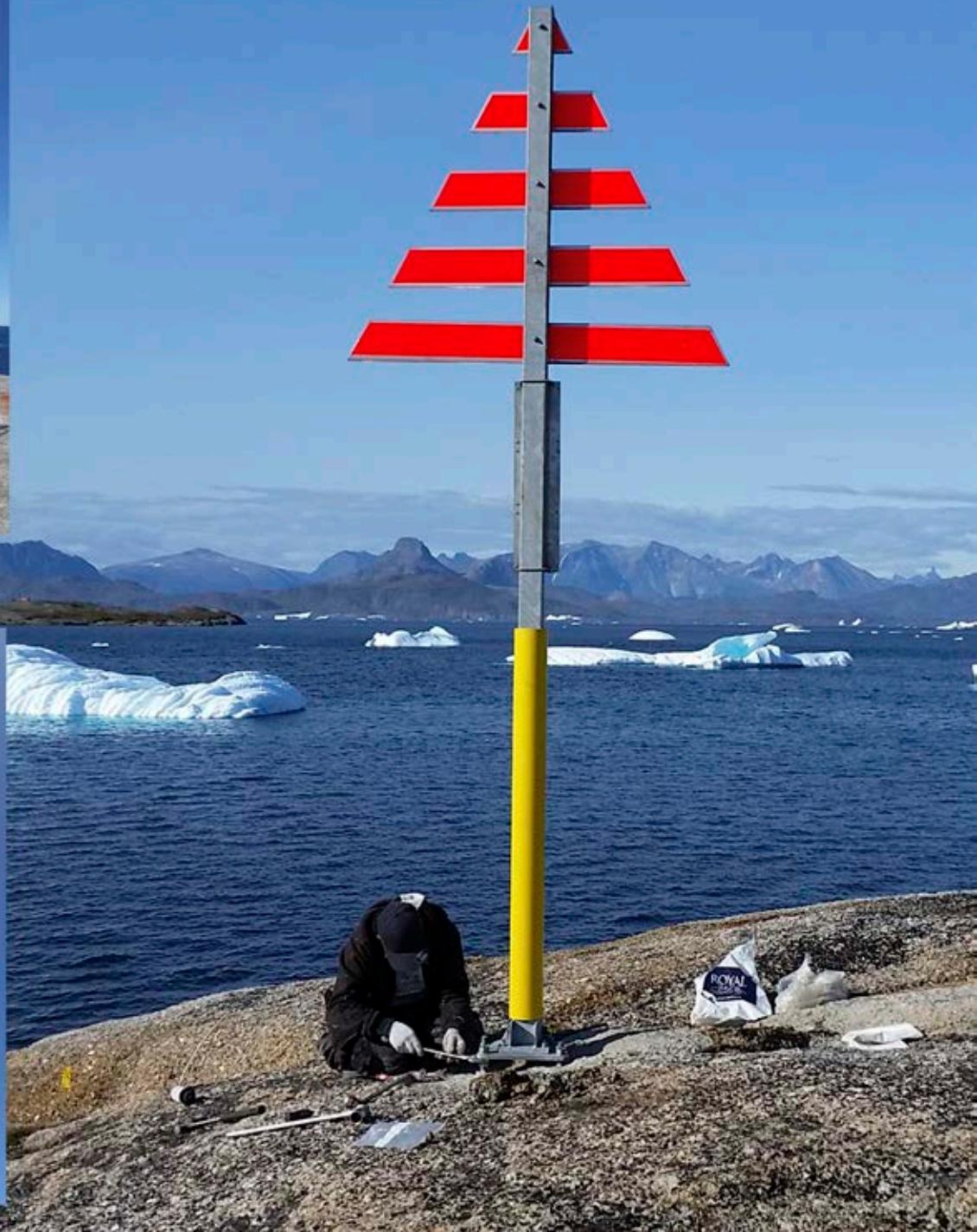
Båker i Grønland (Grønlandsbåker), opsætning og vedligeholdelse efter storm
