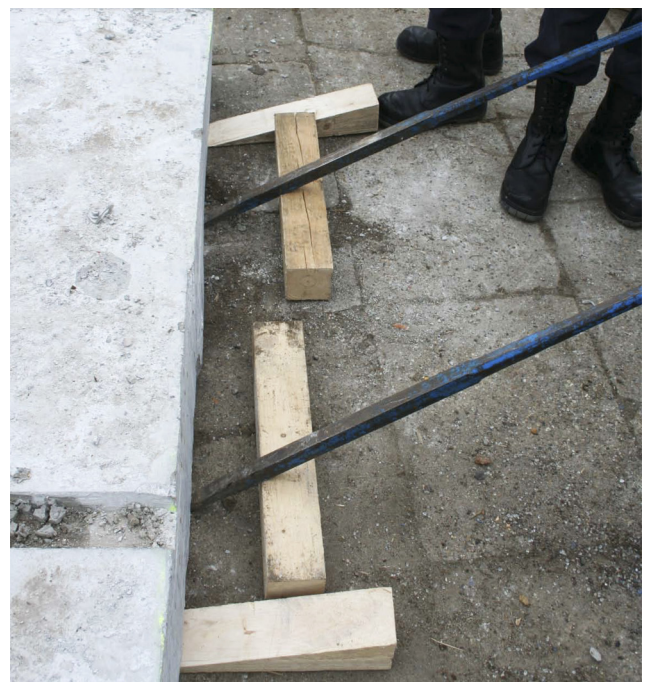
Løftestangen er en undervurderet metode til løft af byrder, men brug af løftestang er en god metode, hvor byrder er helt tæt på underlaget.
