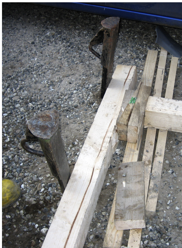
Afhængig af jordbundsforhold kan hvert jordspyd opnå en ankerværdi på op til 500 kg.
