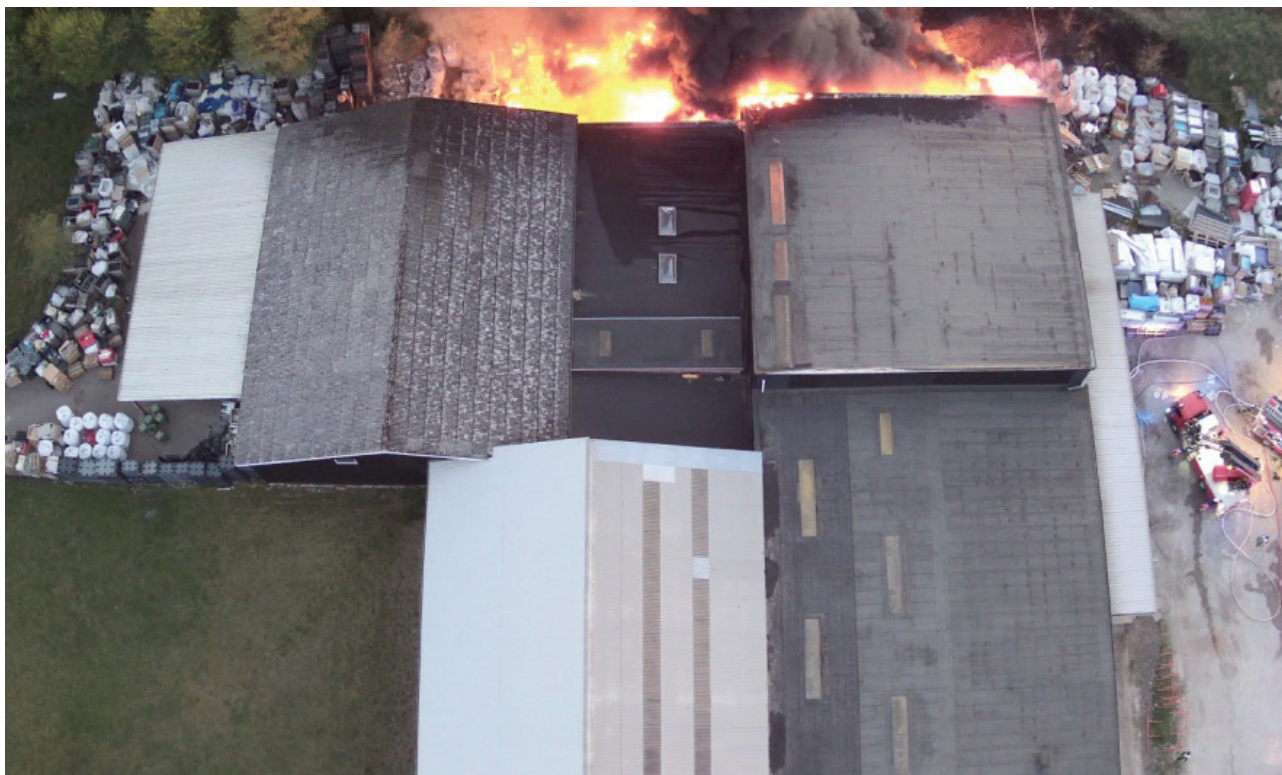
Billede af branden kl. 21:14 viser den svært tilgængelige brand. Branden er fortrinsvis på den ene side af bygningerne, men er allerede trængt ind i bygningerne nærmest branden.
