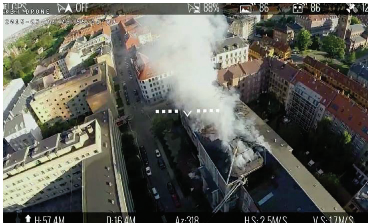
På billedet ses branden, der har spredt sig fra venstre side af bygningen helt ind til den midterste del.
