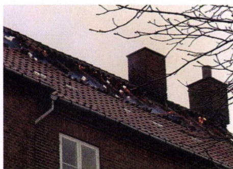
Skorstene kan udgøre en fare, fordi det tømmer, der støtter, er brændt væk.
