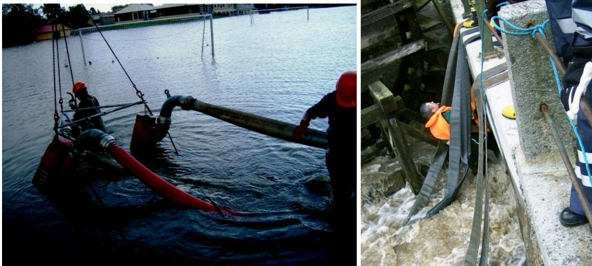
Mandskabet iført waders ved arbejde ifm. oversvømmelse
