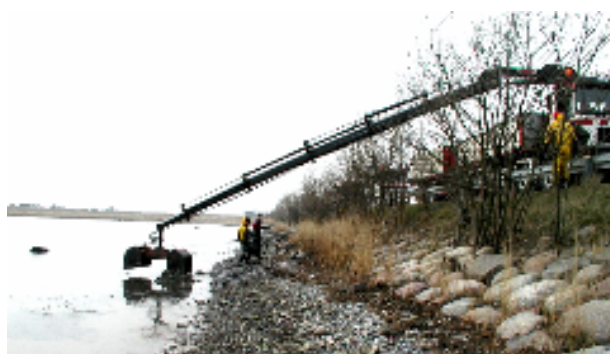
Billede Fejl! Ukendt argument for parameter. Olien "grabbes" op.
